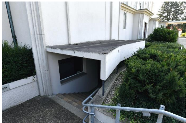
Abbildung 4: Bestehendes Vordach aus den 60er Jahren
