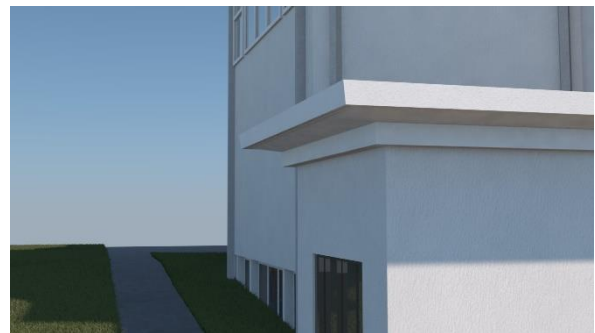
Abbildung 10: Detail Dachrand Lifthäuschen
