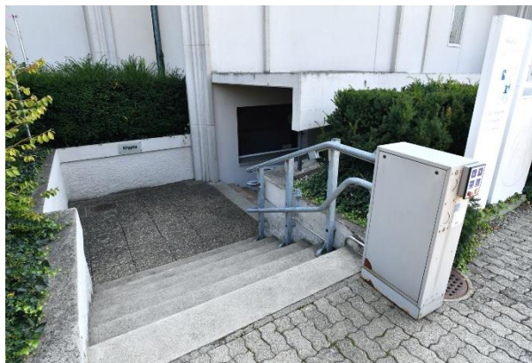
Abbildung 2: Bestehende Aussentreppe mit Treppenlift
