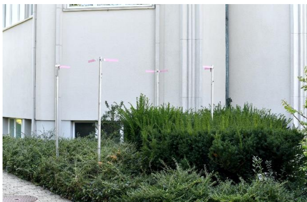
Abbildung 3: Baugespann für das Lifhäuschen
