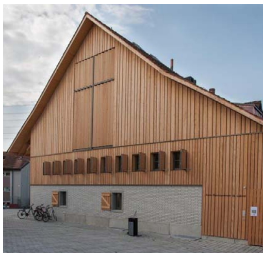
Abbildung 10: Pfarreizentrum St. Gabriel im Haus zum Wiesenthal in Schwerzenbach (nach dem Umbau)
